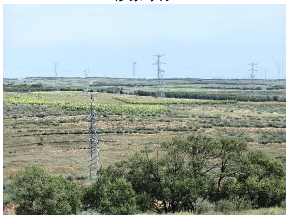
500kV 新荣-平鲁线
