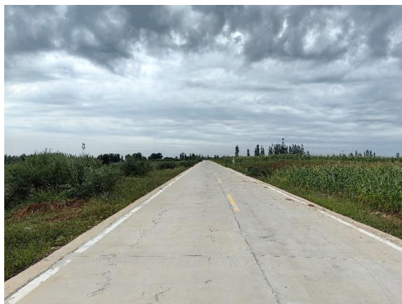
平右 500kV 变电站站址南侧道路
