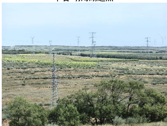
跨越 200kV 圣高线
